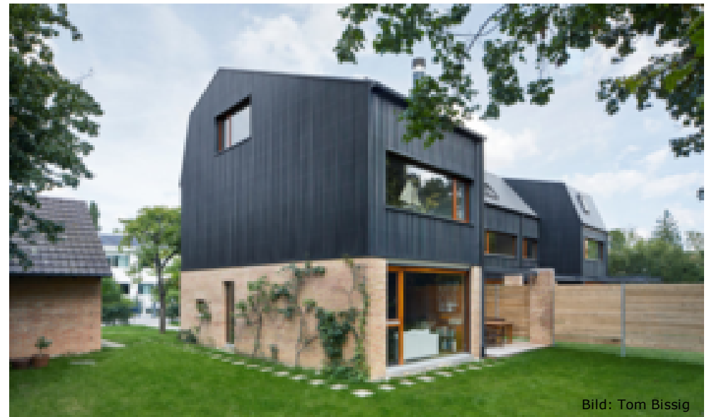
Aufstockung einer Einfamilienhaussiedlung in Münchenstein, Basel
