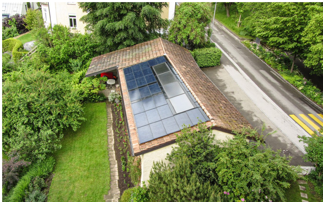
Auf diesem Hausdach wurden Fotovoltaik-Module für die Stromproduktion und Sonnenkollektoren für die Erzeugung von Warmwasser kombiniert. (Foto: zvg)
