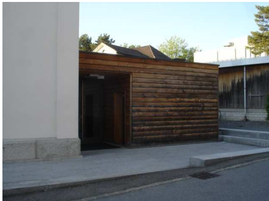
Öffentliche WC-Anlage Haldenstrasse
