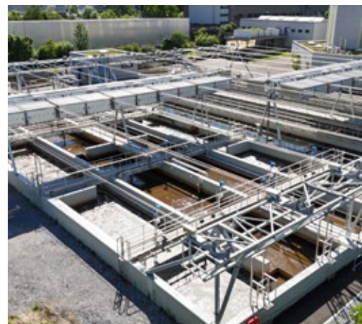
Erfolgreich im Einsatz: Das Solarfaltdach der Kläranlage Glarnerland.
