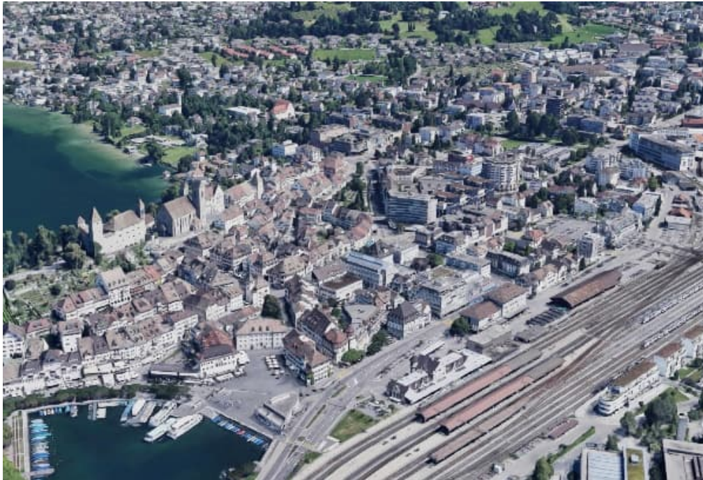
Abbildung 26 Zentrum Rapperswil (Quelle: Google Maps)
