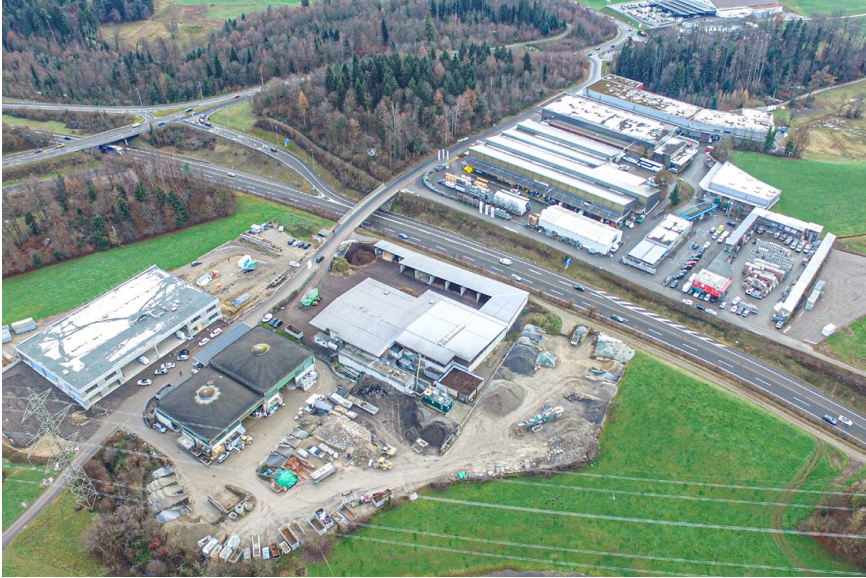
Schon heute wird im Engelhölzli Recycling betrieben und Energie aus Biomasse gewonnen. Nun sollen hier neue Projekte dieser Art realisiert werden. (Foto: zvg)
