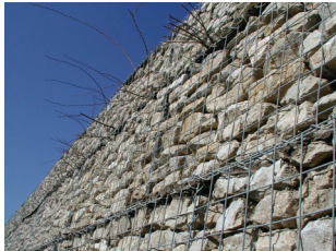
Bepflanzte Drahtschotterkörbe anstelle Betonmauer
