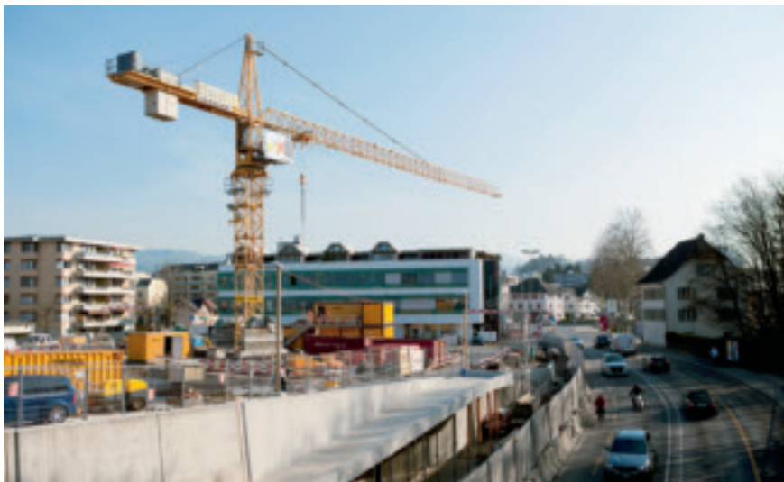
Die Baustelle vonseiten der St. Gallerstrasse mit Radweg- und Fussgängerunterführung.
