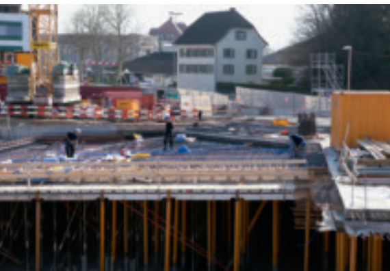
«Stromer» an der Arbeit. Sie legen Leitungen zur Tiefgarage.
