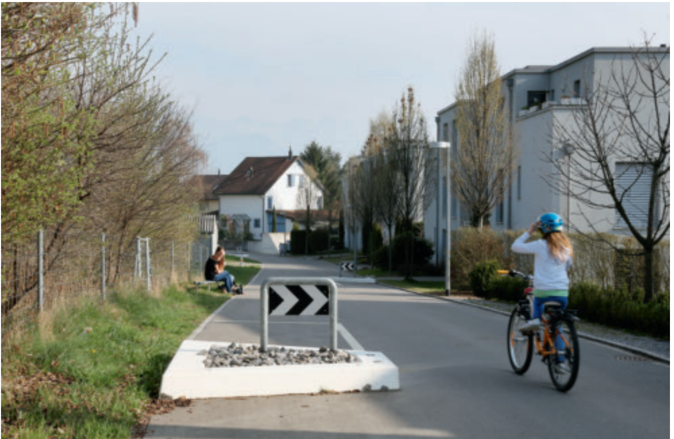
Für die Verkehrsberuhigung setzt die Stadt auf Betontrapeze wie hier an der Rotenrainstrasse.
