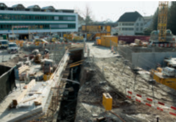
Die Bauarbeiten an der Tiefgarage laufen auf Hochtouren. Über 70 Autos sollen hier Platz haben.
